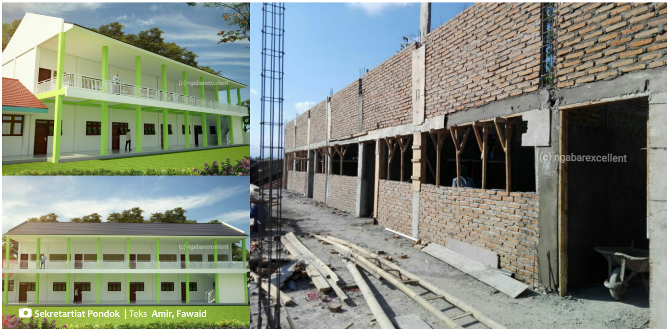
Proses pembangunan dan gambar planning ruang kelas
